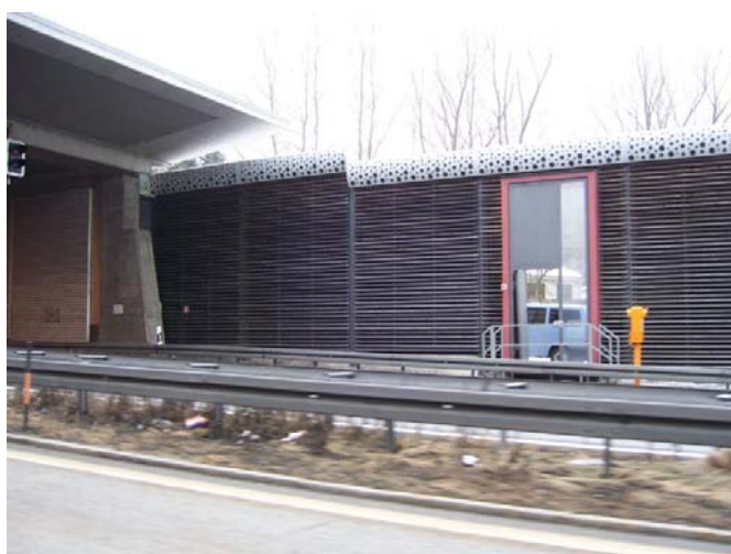
Lärmschutzwand und Einhausung von innen gesehen
