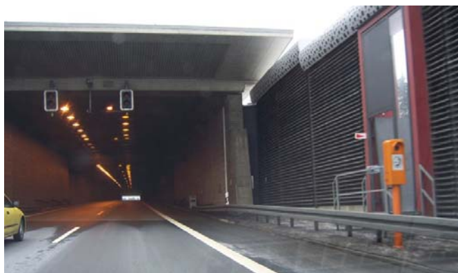
Blick in die Einhausung
