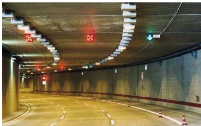
Blick in eine der 2 Tunnelröhren
