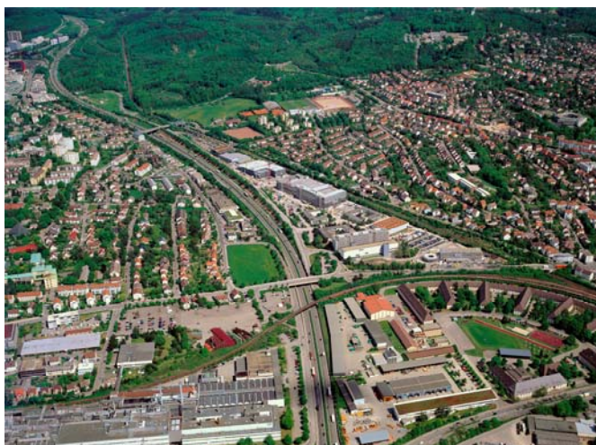
Vorher: Heutiger Iststand. Luftbild der Wohngebiete Viehweide (l.o.), Goldberg (l.m.) und Unteres Lauch (r.o.) durchschnitten durch die A81 Trasse
