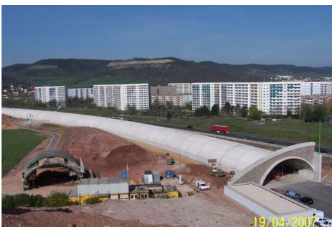
Tunnelaußenansicht vor Überschüttung Blickrichtung nach Erfurt Im Hintergrund Lobeda-West
