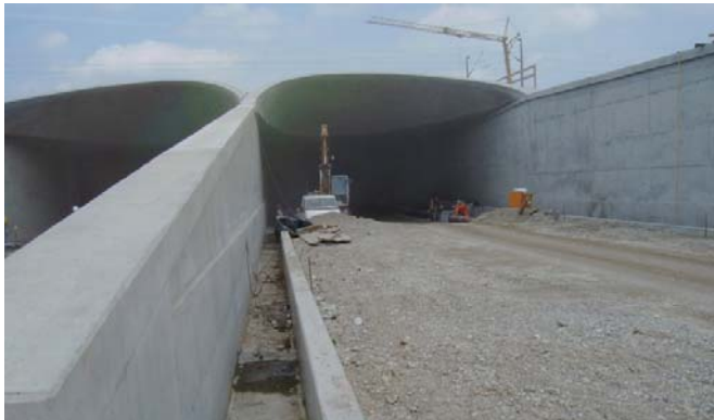
Einfahrt in die Einhausung Aubing vor Fertigstellung
