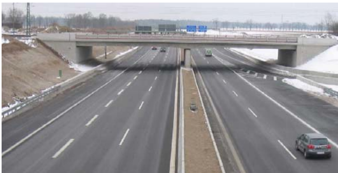
Neubaus der Bundesautobahn A 99 im Teilstreckenabschnitt Unterpfaffenhofen – Aubing. http://riebel.de/fileadmin/dateien/leistungsspektrum/referenzen/Hochbau.pdf
