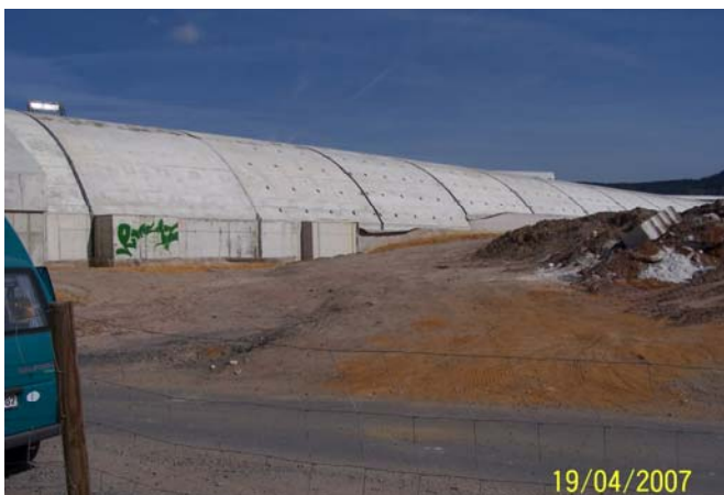
Tunnelaußenansicht vor Überschüttung
