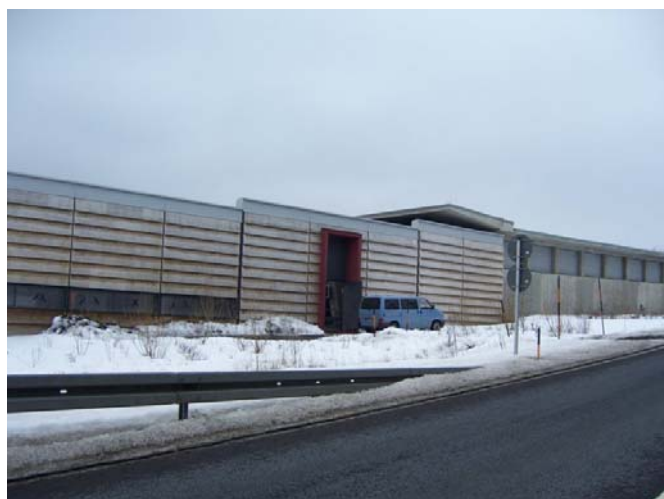
Lärmschutzwand und Einhausung von außen gesehen
