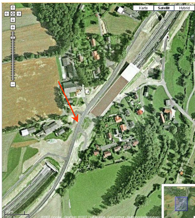
Satellitenaufnahme der fertiggestellten Einhausung
