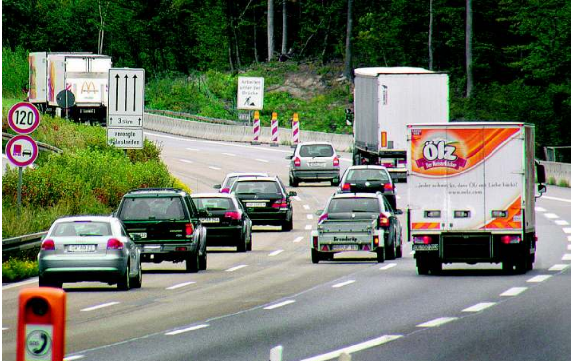
Die verengten Fahrstreifen werden durch den Ausbau auf drei Spuren in jede Fahrtrichtung auf der A 81 beseitigt.
